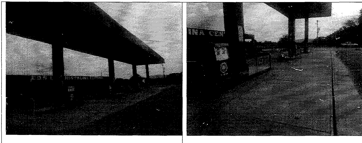
Ilustración 2. Isla o zona de despacho de combustible.
