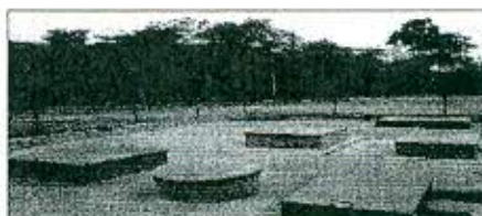
Foto 2. Tanques de Almacenamiento de Combustible.
